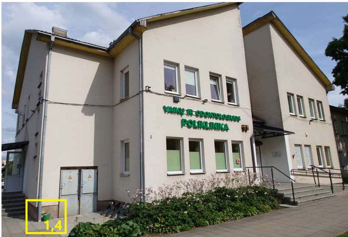
3 pav. Remontuojamo pastato fasado vaizdas.
