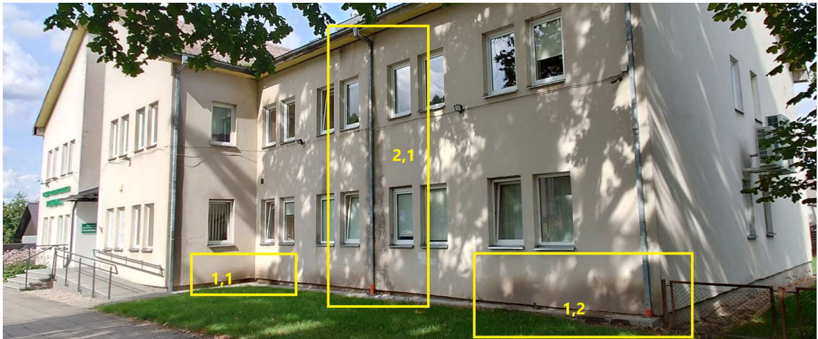
1 pav. Remontuojamo pastato fasado vaizdas.
