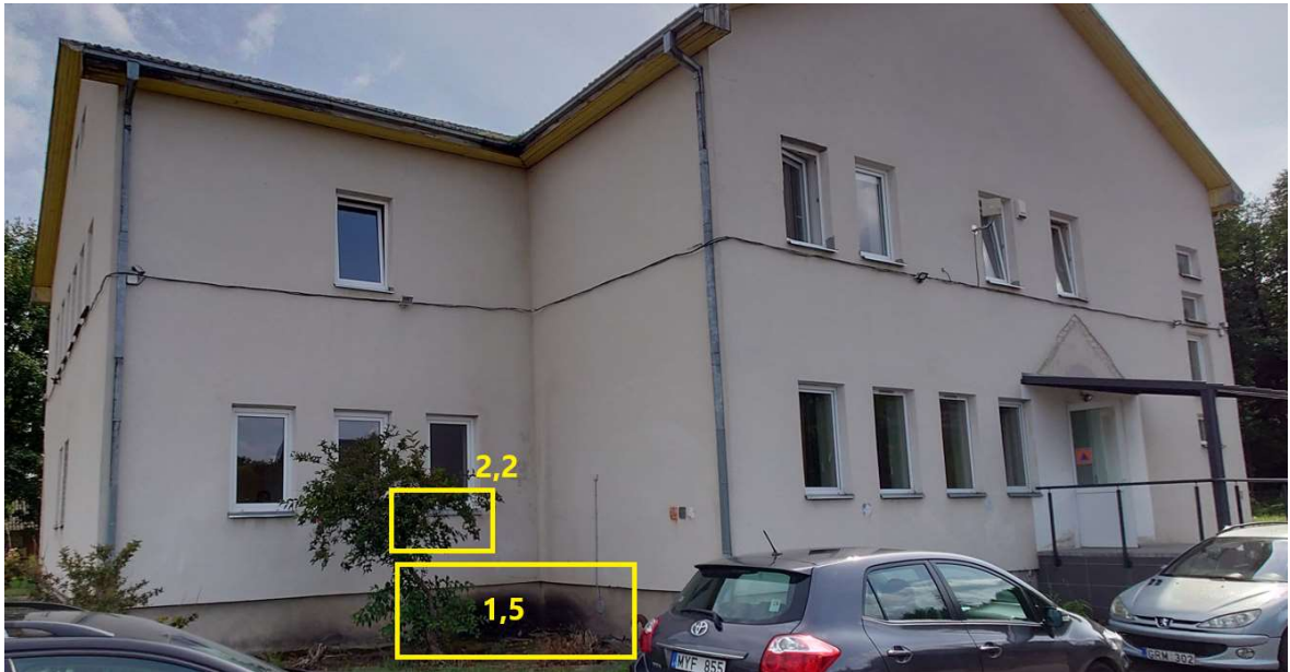
4 pav. Remontuojamo pastato fasado vaizdas.
