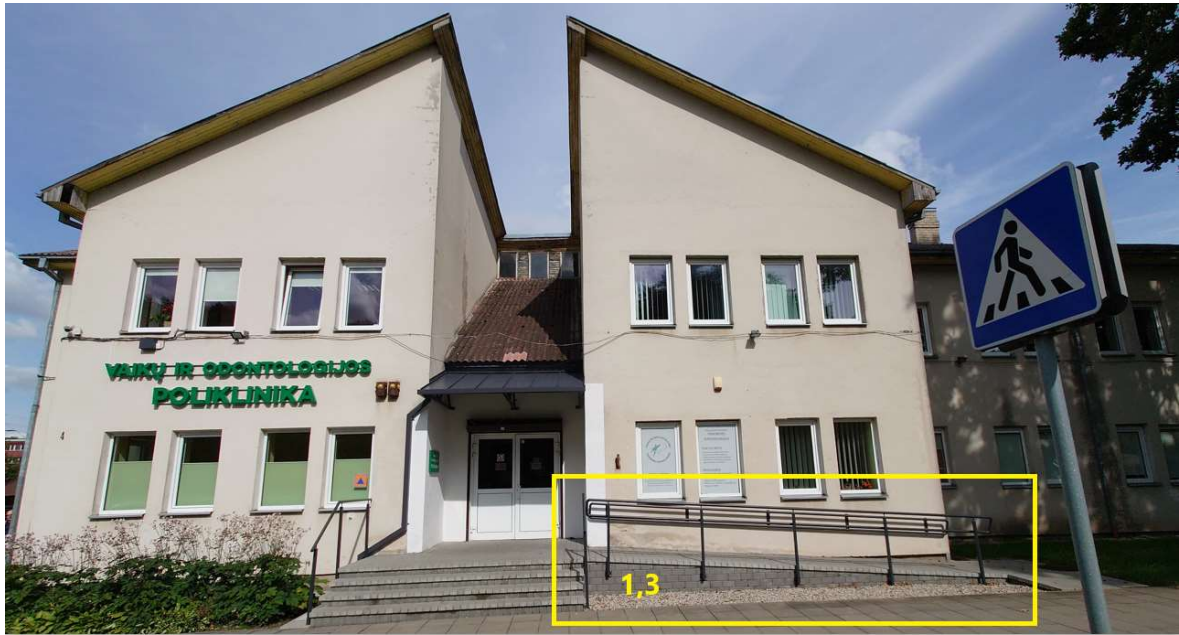
2 pav. Remontuojamo pastato fasado vaizdas.
