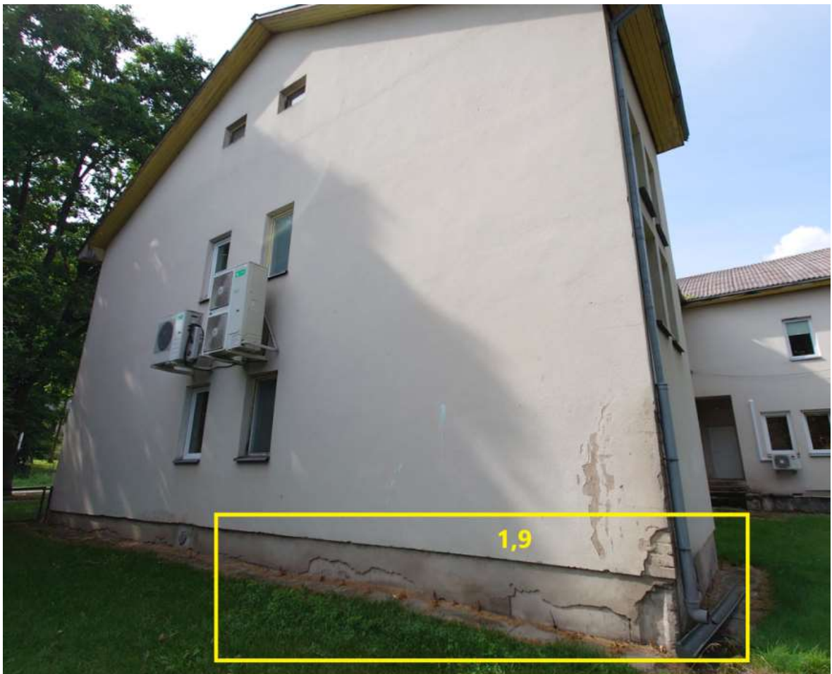
7 pav. Remontuojamo pastato fasado vaizdas
